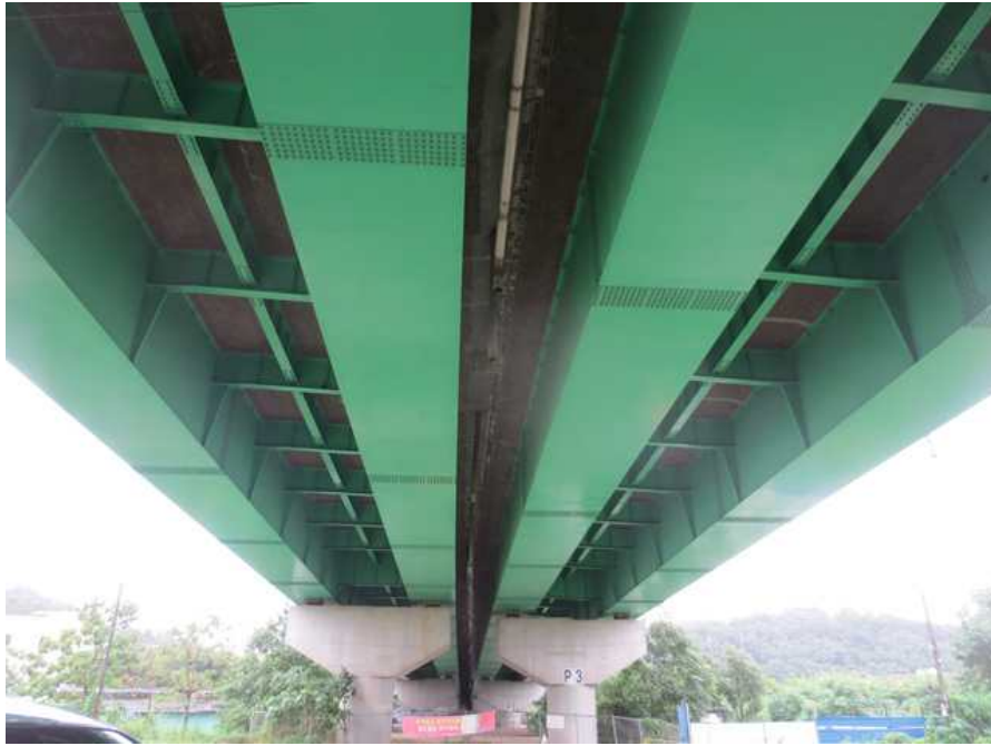
바닥판하면 및 강박스 외부전경
